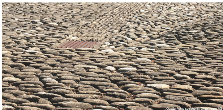
Unvermörtelte Pflastersteinbeläge sind attraktiv und wasserdurchlässig.
