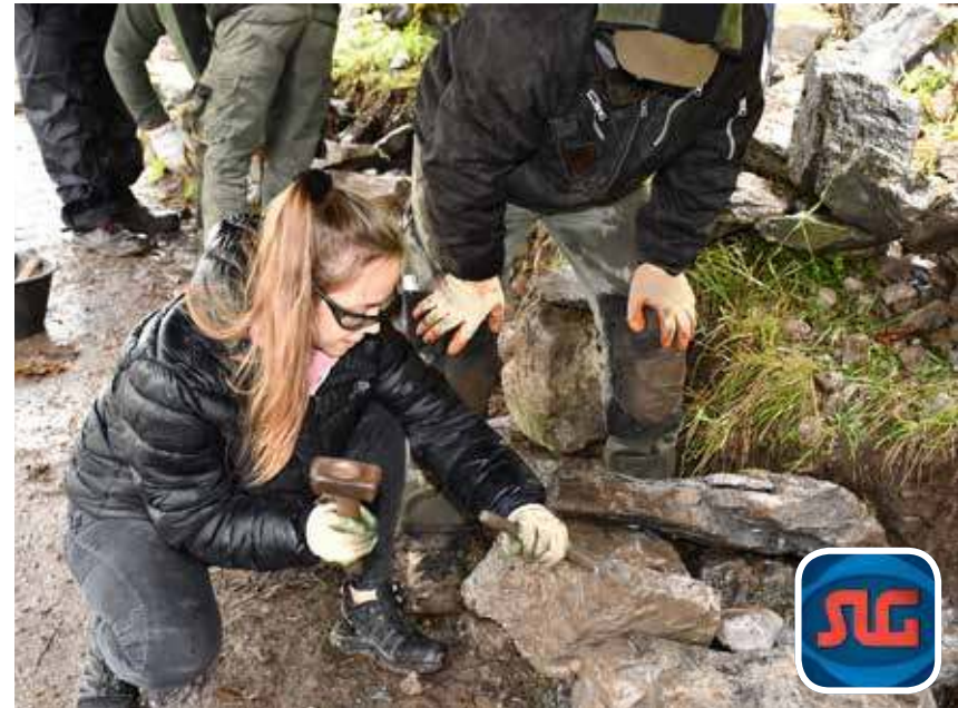
Kein alltäglicher Bürojob: Trockensteinmauern zu bauen, erfordert gutes Augenmass und viel Körpereinsatz.
