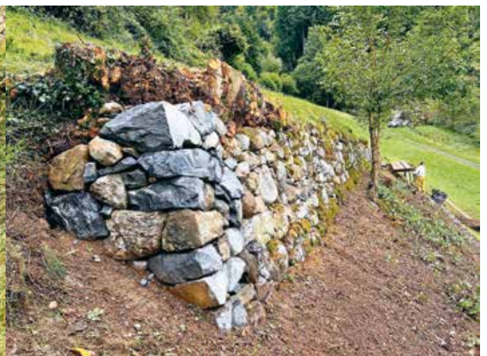
Sanierung Trockenmauern Tünelen, Walenstadt
