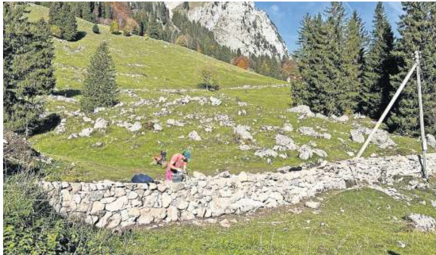
Trockenmauer auf der Alp Gspaa während den Sanierungsarbeiten.
