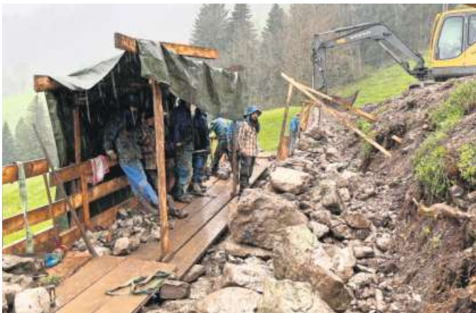
Bei Wind und Wetter wird an der Trockenmauer gearbeitet.
