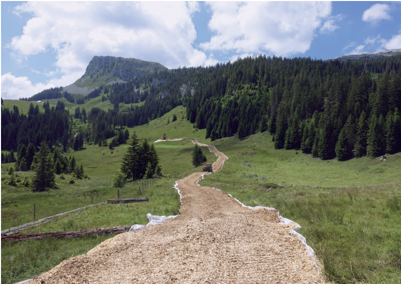
Baupiste aus Holzschnitzeln zum Schutz des darunterliegenden Bodens
