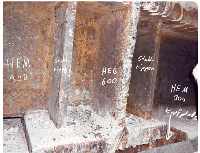
Sondagnaufnahme der Abfangung Decke über EG in Stahlbau © suisseplan
