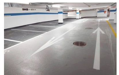
Total saniertes Parking, Bereich Coop © suisseplan
