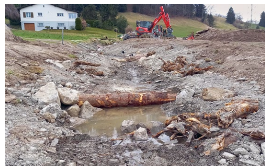
Ausführung Giessenbach Ost, Feusisberg (SZ)
