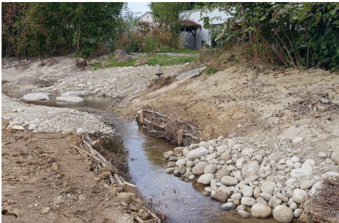
Uferfaschinen bei der Revitalisierung Talbach, Hirschthal (AG)
