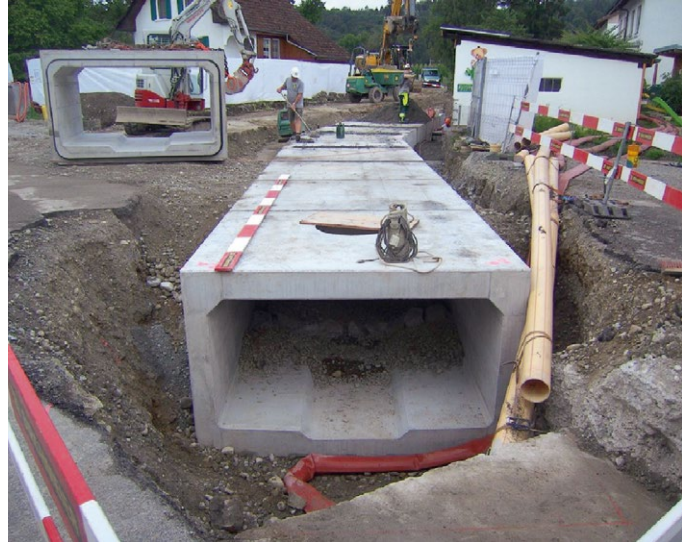
Durchlass beim Krebsbach in Hendschiken (AG)
