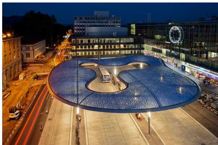
Blick vom Aarauer Hof auf das Bushofdach; die Perronbeleuchtung wirft den Tischschatten auf die blaue Oberfolie © Niklaus Spoerri, Zürich
