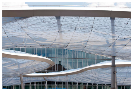
Bei schräger Sicht auf das Dach wird es skulptural und verhindert eine Einsicht in den Kissenhohlraum und den darin verborgenen Stahltisch © Niklaus Spoerri, Zürich
