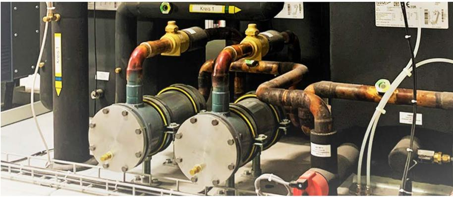
■ Von der See-Energie Zentrale fließt das Wasser in die Quartierzentralen. Dort erfolgt der Temperaturhub mit einer Wärmepumpe.
