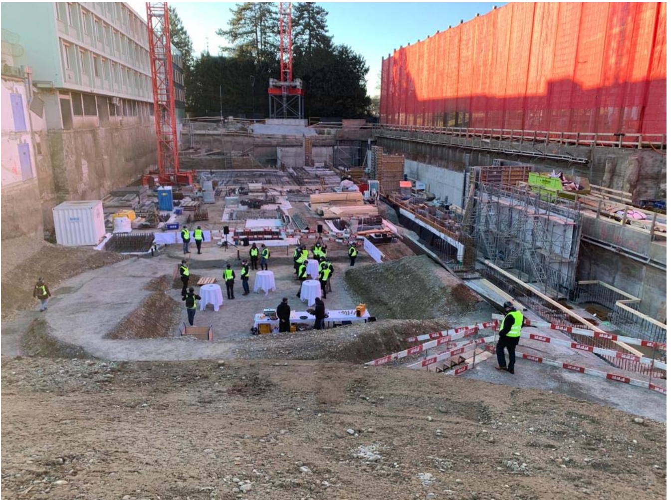
Baustelle der Bezirksanlage Winterthur Quelle: BD
