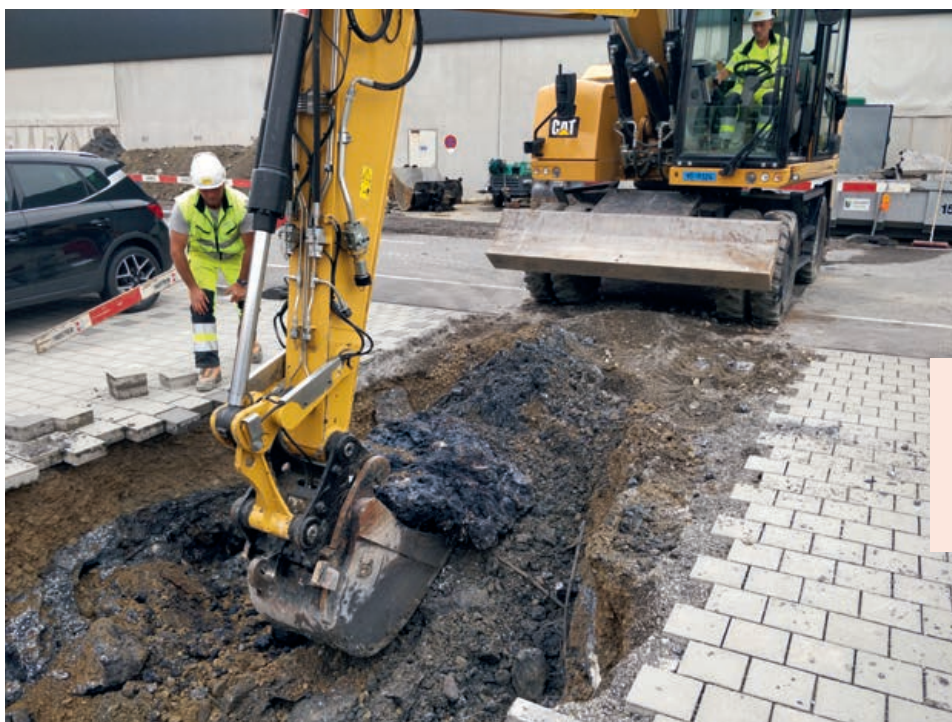
Aushub Altlasten © suisseplan, Juni 2019
