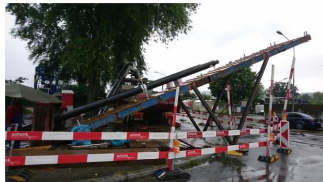
Rohrbauplattform für Querung Autobahn zu ZSC Stadion mit 2xDN250 KMR plus 2x 560 Anergie.
