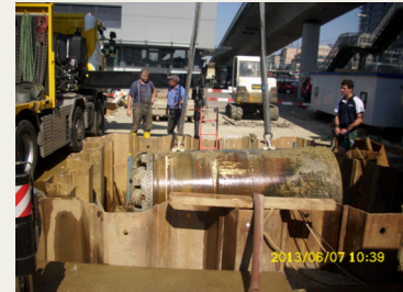
Bild: Bergung Bohrkopf Microtunnel
